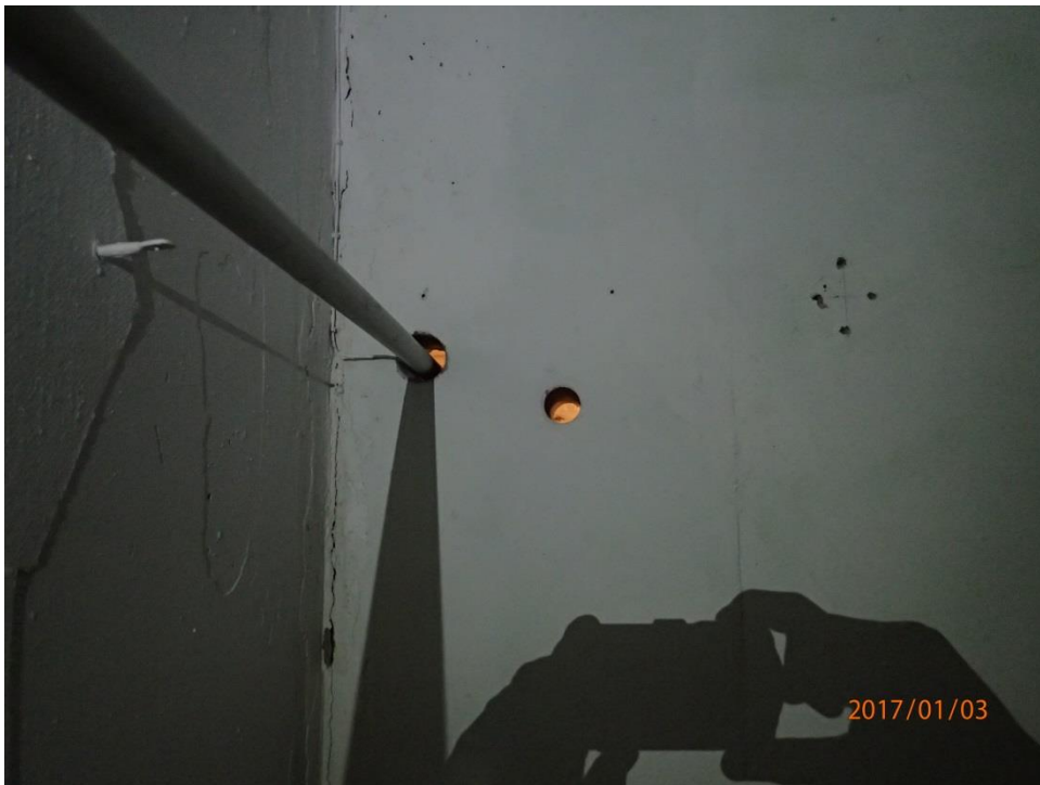
Bild 5: Otätheter mot garage i brandlokalens källare
