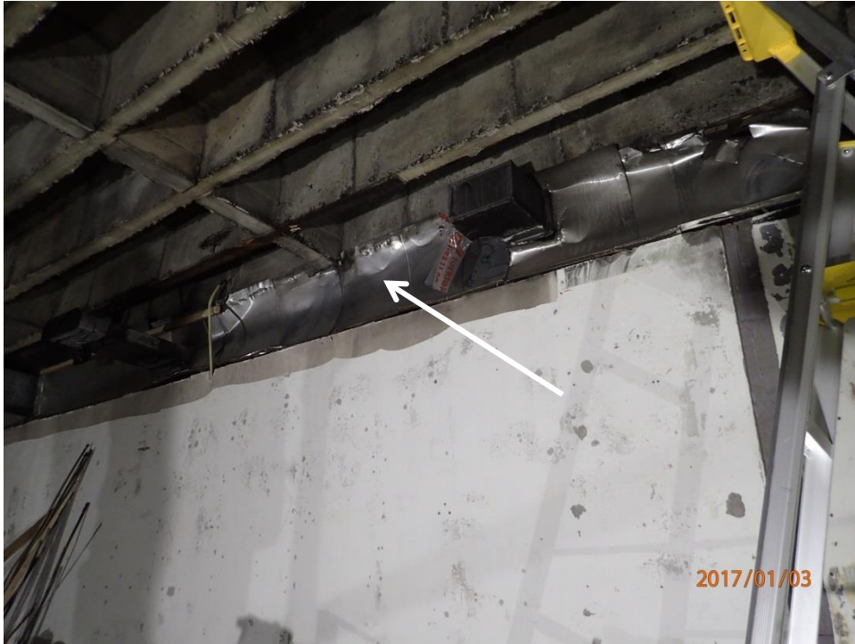
Bild 4: Pilen visar plåtavskiljning mot frisörsalong
