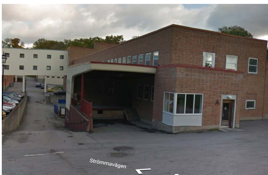
Angreppsvägen under skärmtaket.
