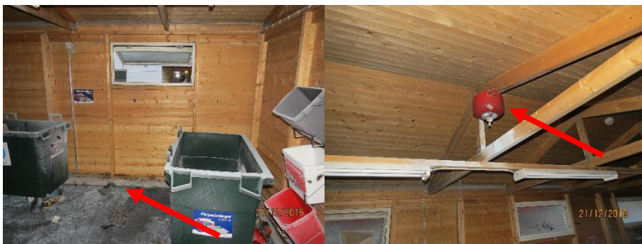
Bild 3 och 4: Röda pilarna visar platsen där sopkärlden stod och en av de pulversprinkler som aktiverats.
