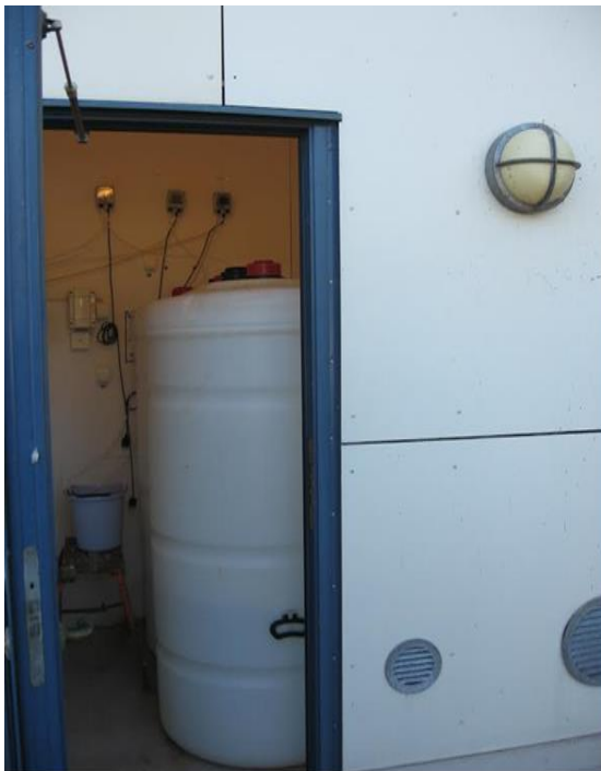
Bild 2. Rummet där tanken med saltsyra stod.
