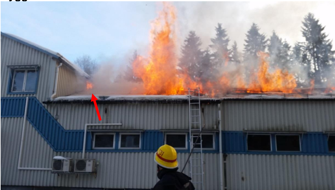
Bild visande branden i envåningsdelens vind. Observera flamman invid tvåvåningsdelens vägg
