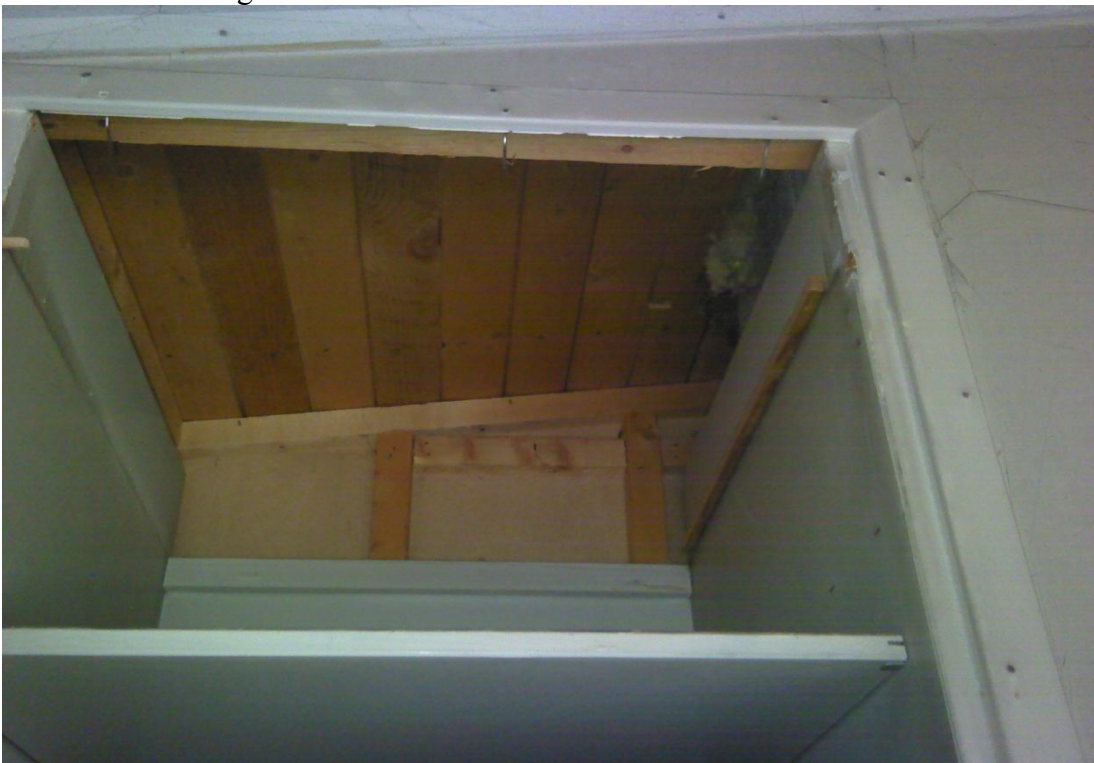
Takkonstruktionen sedd från en garderob
