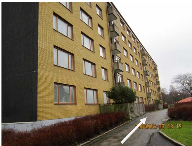
Bild 3. Baksidan av huset, där även räddningsvägen (pil) syns.
