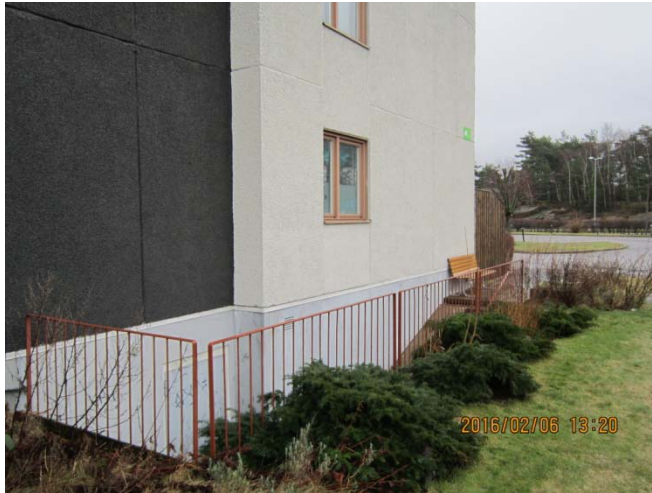
Bild 2. Ingång till gemensam källare. Finns på båda gavlarna av huset.
