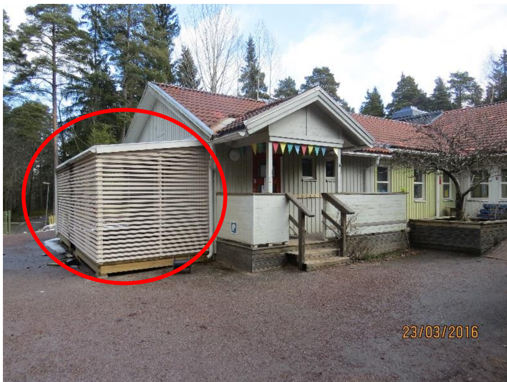
Bild 1: Den röda ringen visar barnvagnsförrådet.
