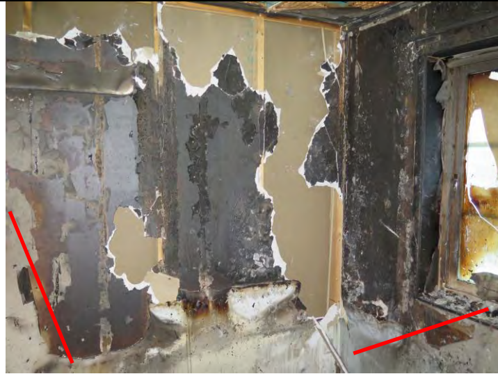
Figur 4, visar brandrummet. Sängen stod placerad i detta hörn. Mitt på sängen började branden. Röda streck illustrerar vad som liknar ett brand-V.
