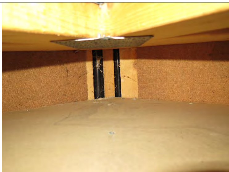
Figur 3, visar taknocken på vinden. Fuktsparren är en tydlig svaghet gentemot den andra lägenheten.
