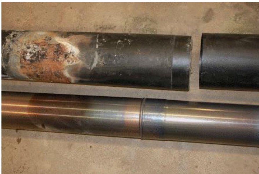
Bild 6. Det syns även tydligt på innerröret att det varit rejäl hög temperatur i den del som varit isolerad i bjälklaget.
