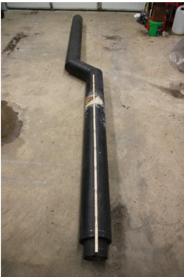
Bild 4. Systemskorstenen nermonterad
