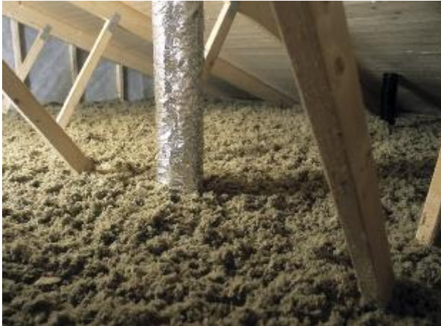
Bild 3. Så här kan en vind se ut med lösullsisolering. (bilden är ej från brandplatsen)
