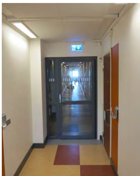
Bild 4 Vy från korridor andra sida brandcellsgränsen
