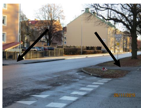
Bild 3: pilarna visar stråk och nedsänkta kantstenar
