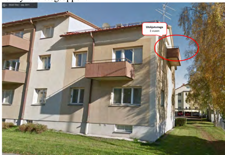
Bild 4 Visar balkongen där person från 4:e våningen evakuerades från med utskjutsstege. Bild hämtad från Google StreetView.
