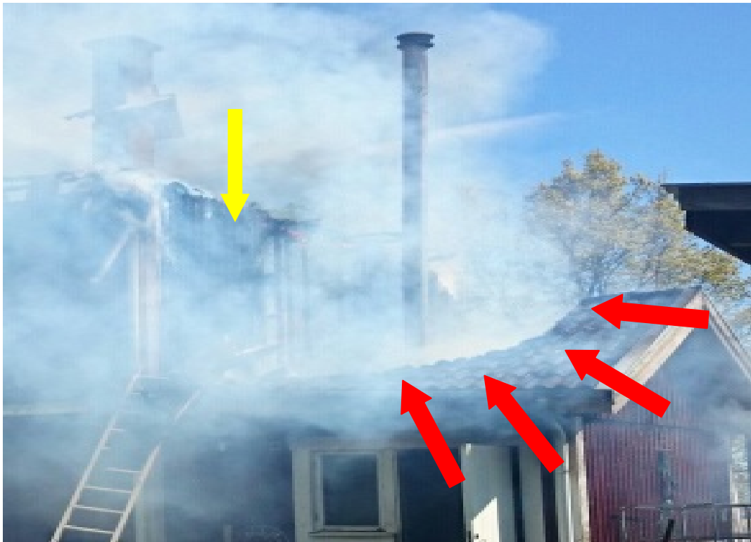
Bild 5. Dom röda pilarna visar kraftig urbränning av taket till pannrummet, den gula pilen visar hur bränd panelen är som ligger ovanför taket till pannrummet.
