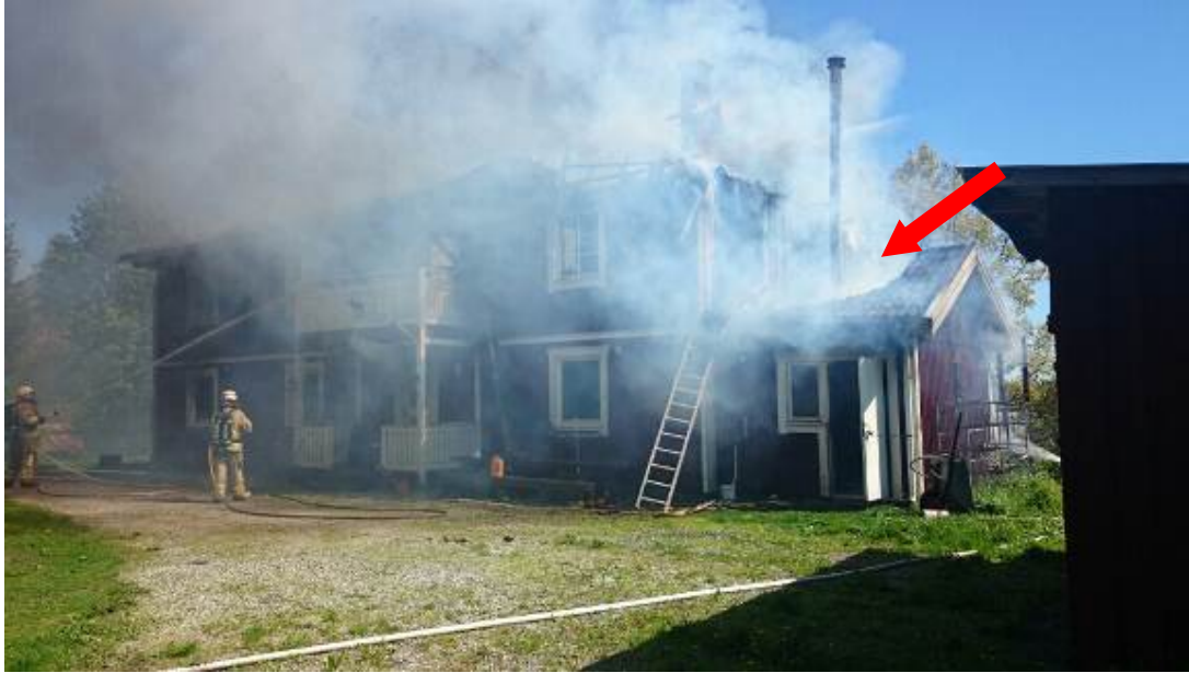
Bild 4. På denna bild kan man tydligt se att taket till pannrummet är urbränt runt skortensröret
