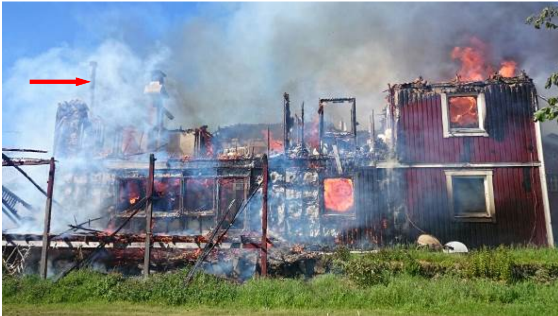
Bild. Tagen på baksidan av byggnaden, röd pil visar skorstensröret.
