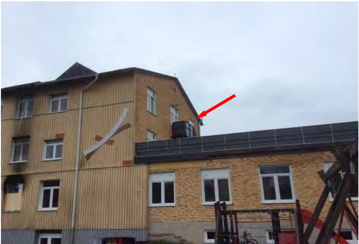
Bild 23 Utrymningsväg i väster på våning tre.
