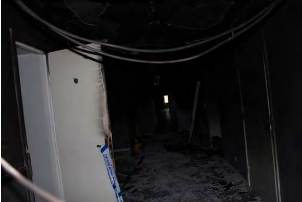
Bild 5. Brand och värmeskador på korridoren bottenplanet, kort taget från den östra sidan. Denna korridor är 50 meter lång.
