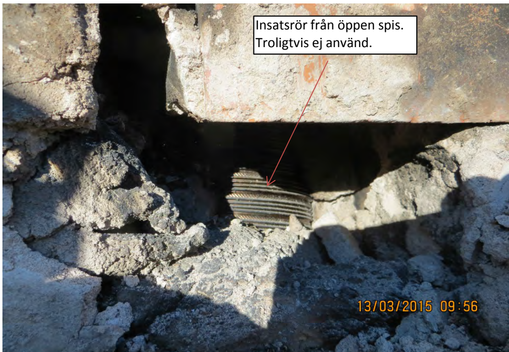
Här har undertecknad knackat bort murverket för att kunna inspektera runt insatsröret.
