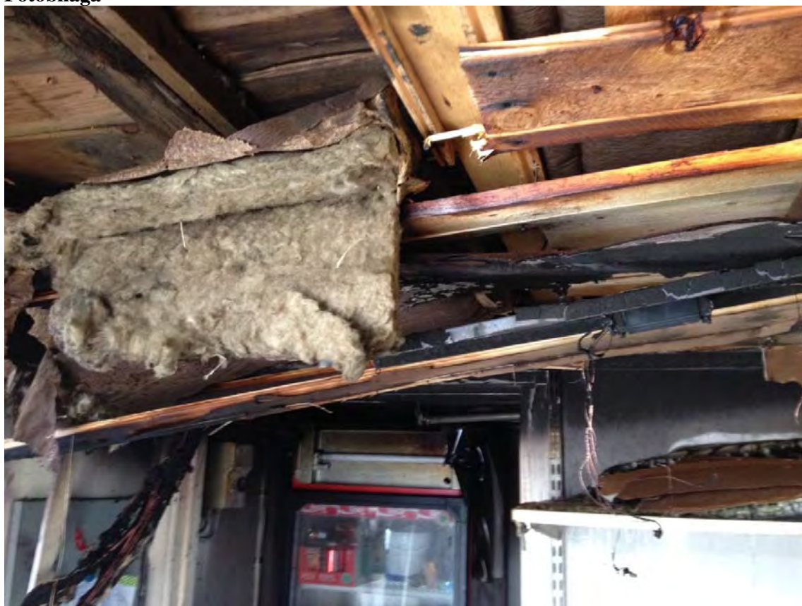
Bild 4. Innertaket bröts upp för kontroll.
