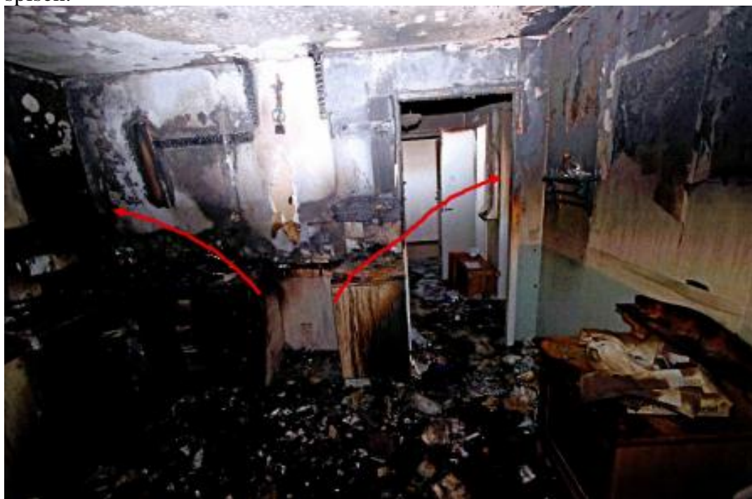
Figur 5 Väggen bakom spisen visar ett Brand-V
