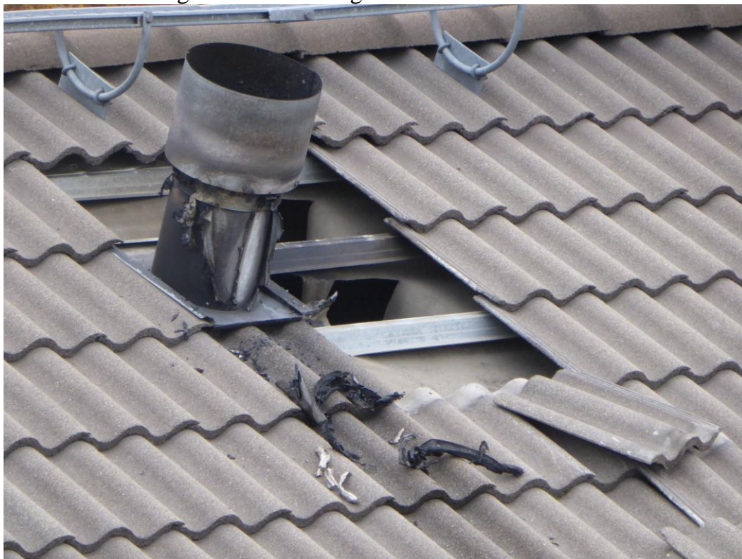
Figur 10 Imkanalen från utsidan, tydliga tecken på brand eller värme
