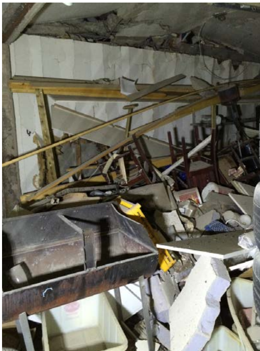
Bild 6. Explosionsutrymme med bjälklaget som lyft. Foto: Västra Mälardalens Räddningstjänst
