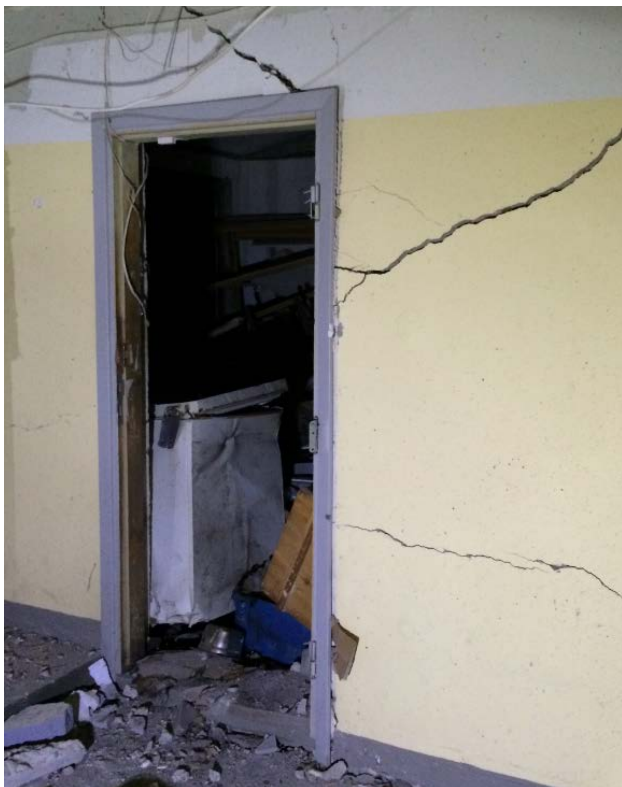
Bild 14. Förrådet med frysboxen direkt innanför dörren. Foto: Västra Mälardalens Räddningstjänst
