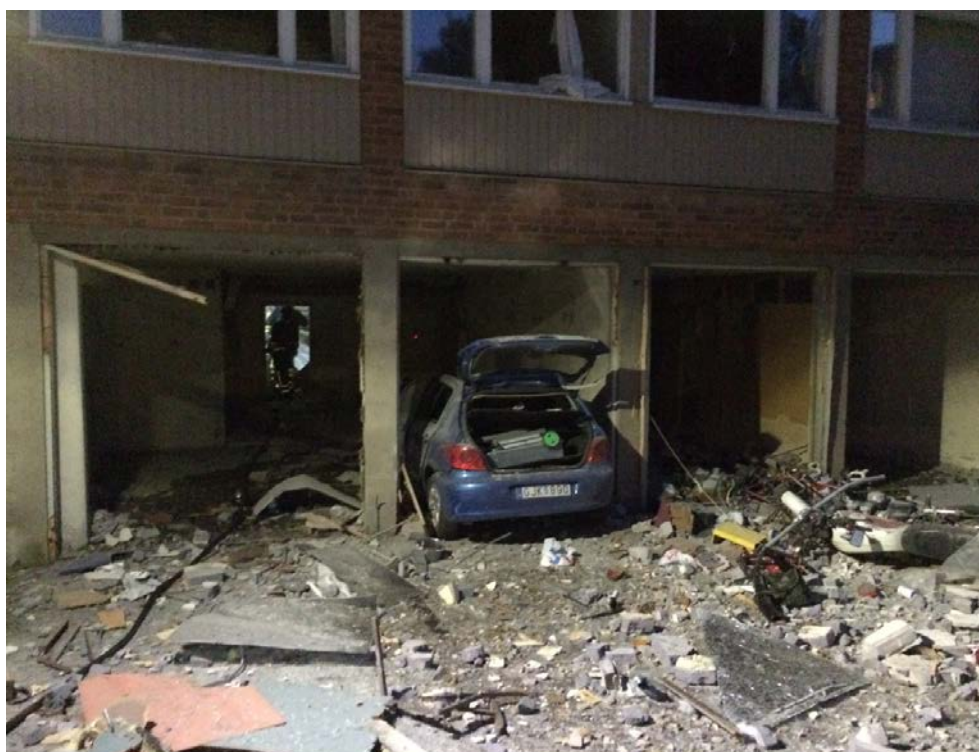
Bild 12. Rökdykare på väg in i explosionsutrymmet. Foto: Västra Mälardalens Räddningstjänst
