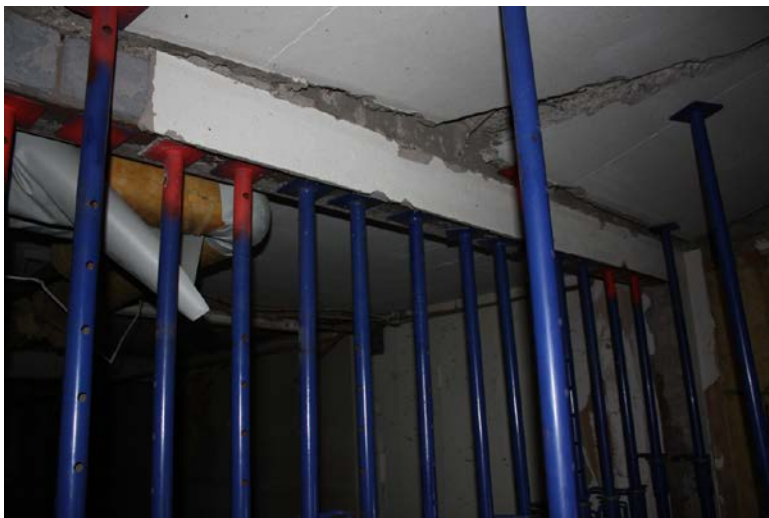
Bild 11. Säkerhetsstämning av bjälklag och bärande balk. Foto: MSB
