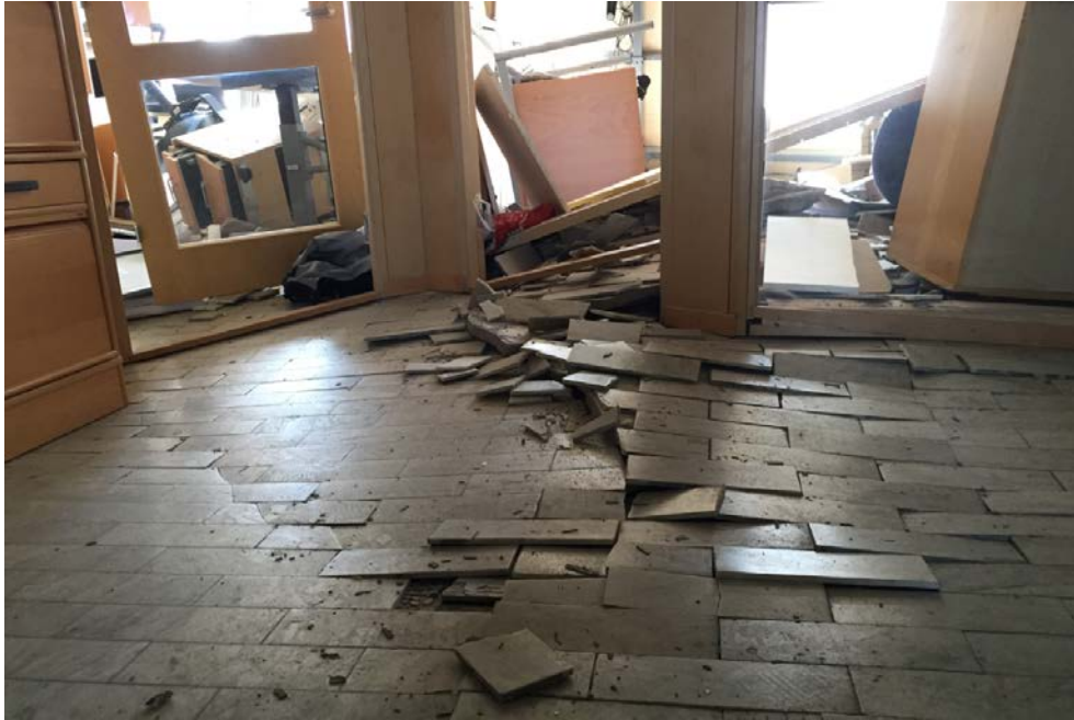
Bild 8. Kontor mot Herrgårdsgatan. Foto: Byggnadsfirma Lund AB
