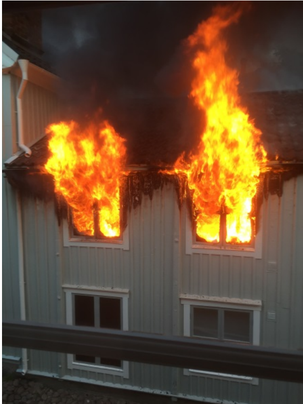
Figur 14: Lågor som slår ut ur fönstren mot Arendt Byggmästares Gata klockan 06:00.
