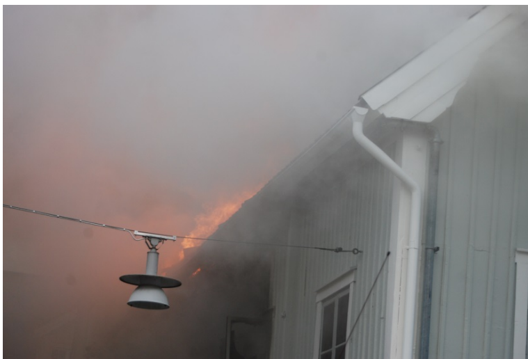
Figur 29: Den vajer som takfoten fångas upp utav. Fotot är taget klockan 06:40. Foto: Leif Ygbrant
