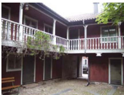
Figur 6: Innergården, fasad mot söder och väster.
