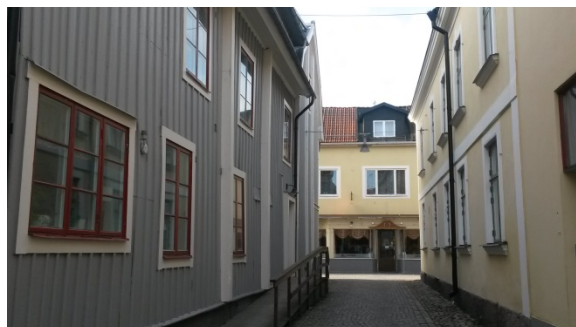
Figur 36: En av gränderna som försetts med brandklassade fönster.
