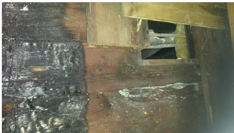
Figur 23: En av flera öppningar i väggen i lågdelen på innergården som tidigare inte varit synlig.
