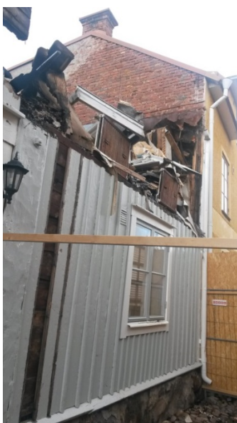
Figur 19: Den brandmur som stoppade brandspridningen norrut längs Arendt Byggmästares gata.
