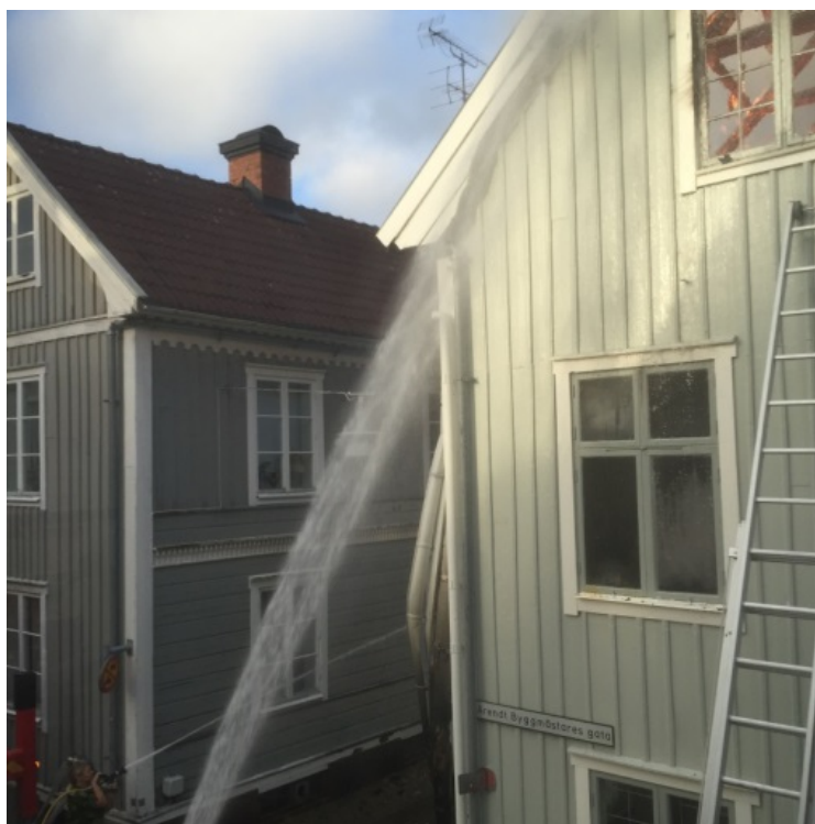
Figur 17: Klockan 06:54 hjälper Försvarmakten till med att hålla nere branden mot Vaxblekaregränd och mot Arendt Byggnästares Gata. Fasadsprinklerna är ännu inte trycksatta och takfoten på den brinnande fastigheten har nyligen fallit ner och hänger längs fasaden mitt i bild.
