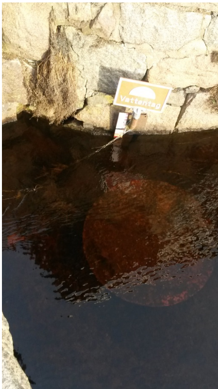
Figur 10: En av tre iordningställda uppställningsplatser för motorsprutor vid Eksjöån.
