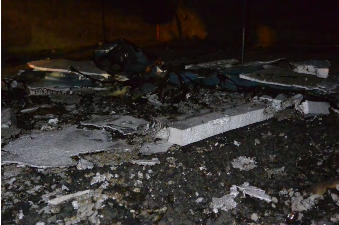
Bild 6. Frigolit på golvet/marken inne i grunden.
