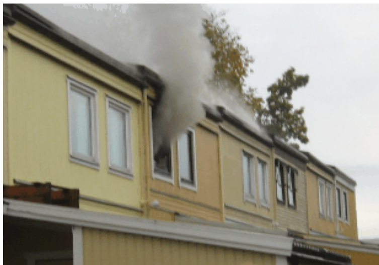
Bild 3. Större delen av brandgaserna gick ut i det fria tack vare att takfoten slutade jämnas med husfasaden.
