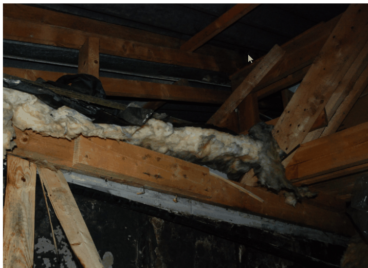
Bild 5. Bjälklag mellan bostad och vind.
