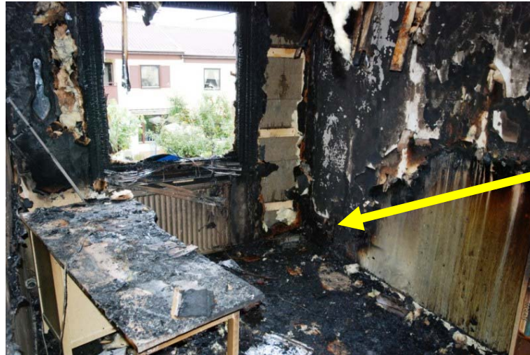
Bild 4. Det karaktäristiska brand-v:t visar var branden har startat.
