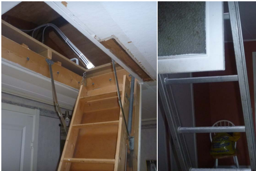
Bild 6. Till vänster – grannen till brandutsatt bostad har bytt ut tidigare glaslucka mot vind. Till höger – del av vindslucka i glas i brandutsatt lägenhet.
