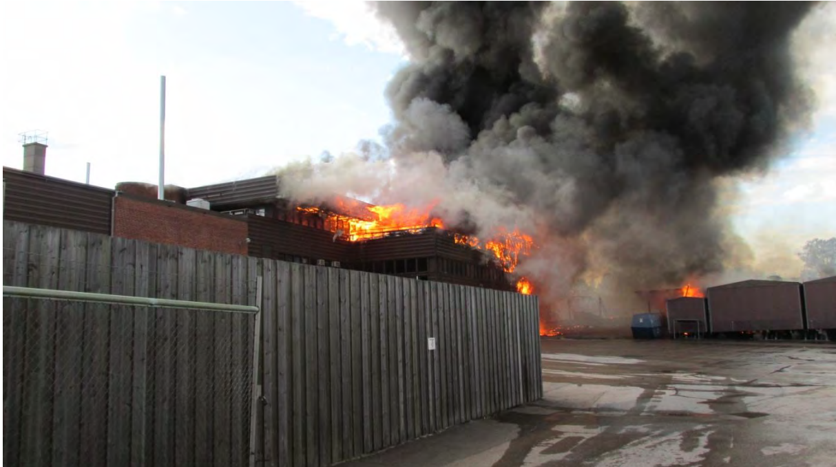
Bild 7 Livsmedelsindustrins takkonstruktion och kontorsdel antänds av takbranden på industrins utlastning
