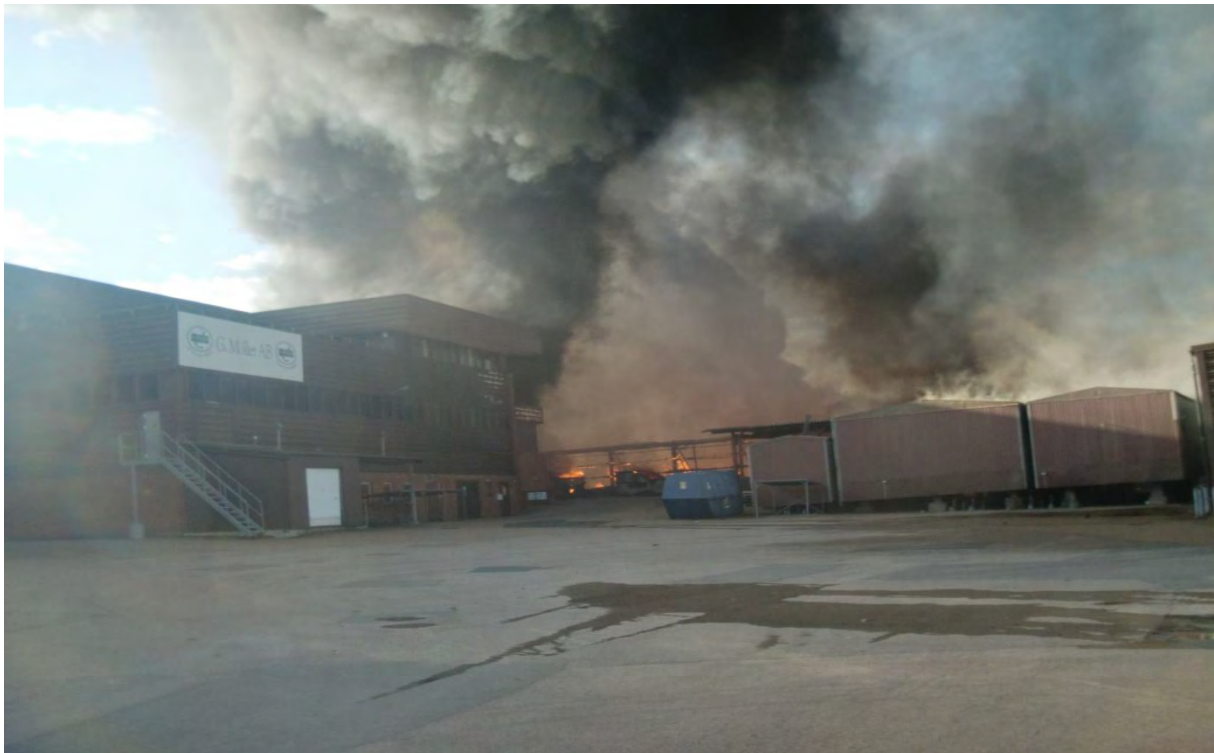
Bild 6 Takkonstruktionen på livsmedelsindustrin utlastning brinner
