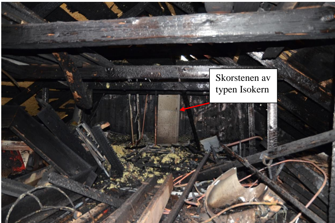
Rännnet ovanför pannrummet.
