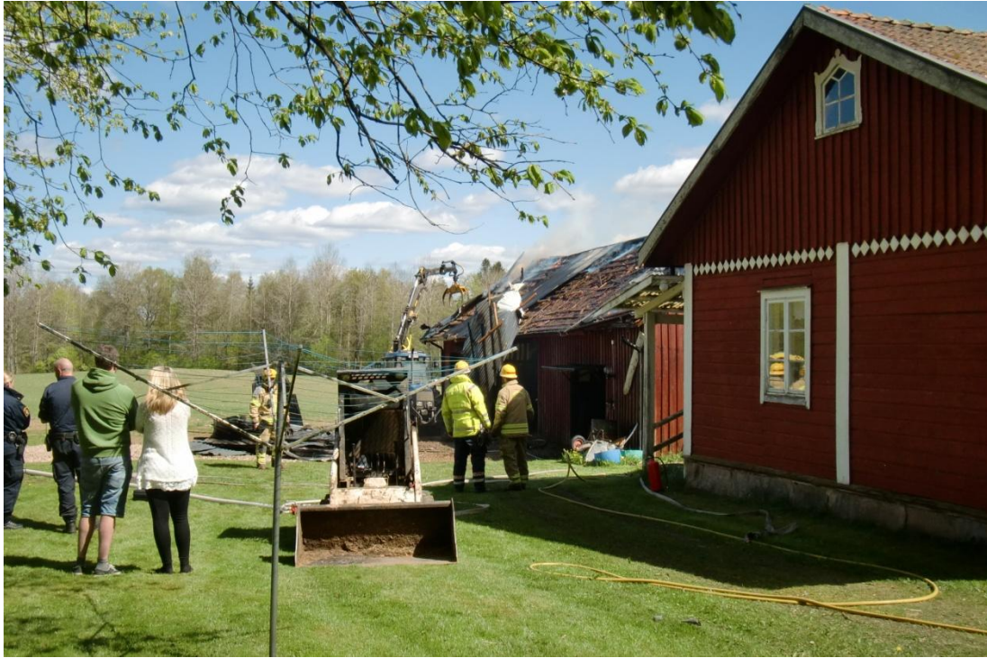
Att använda en skogskär med kran underlättar arbetet med att ta bort plåtbeklädnaden avsevärt.
