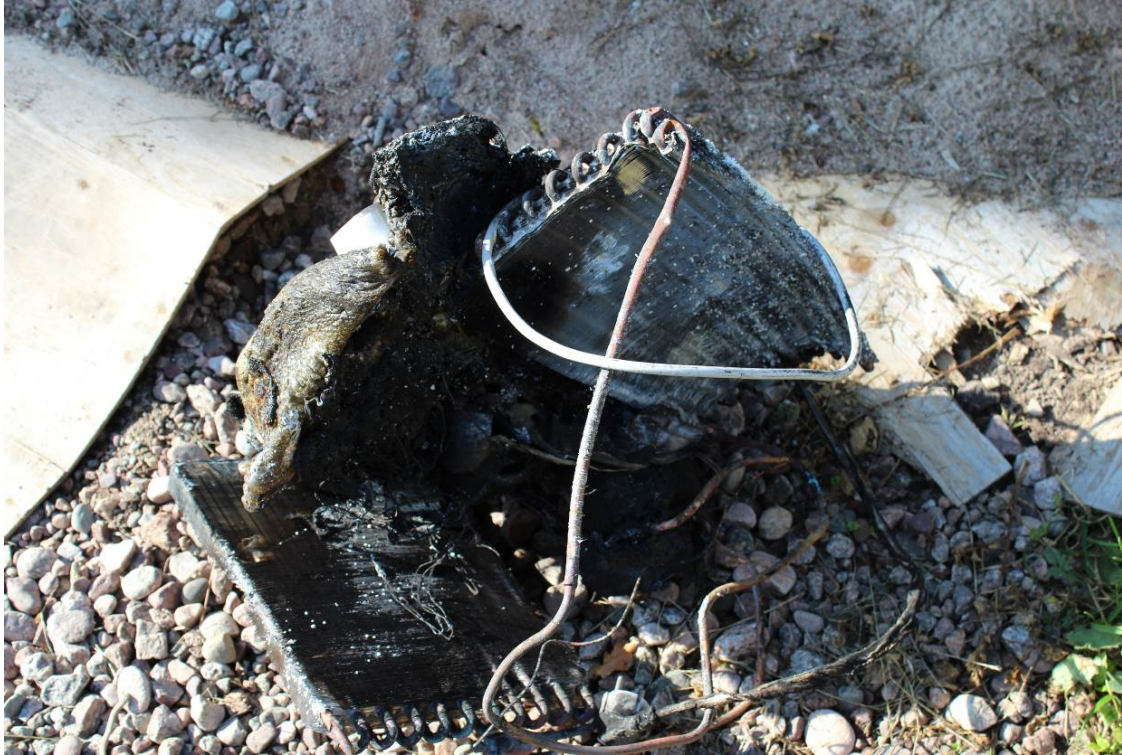
Bild 5. Den brandskadade avfuktaren av märket Woods MDC20.
