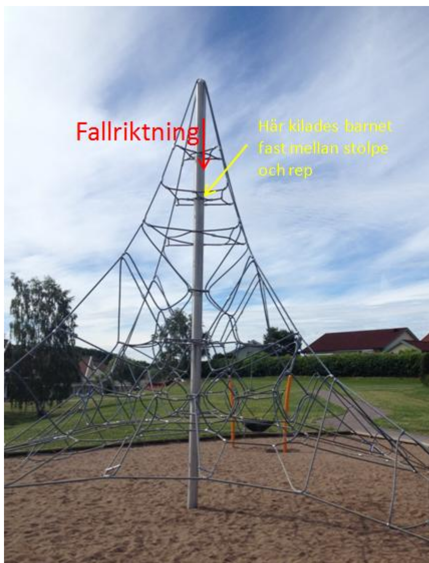
Figur 3 - Den aktuella klätterställningen med olycksplatsen markerad
