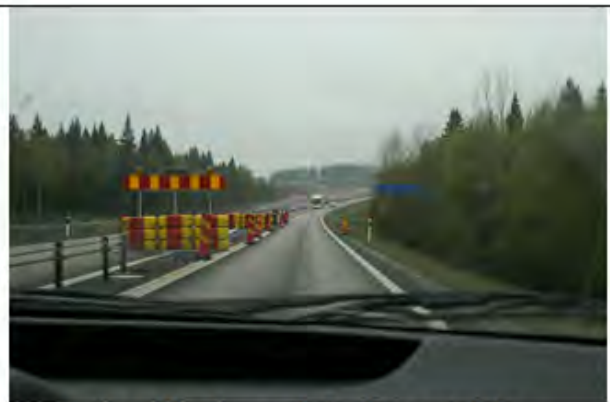
Foto tagit ca 400 m innan olycksplatsen, skylt för mötande trafik och tydlig markering att vajervägen upphör.
