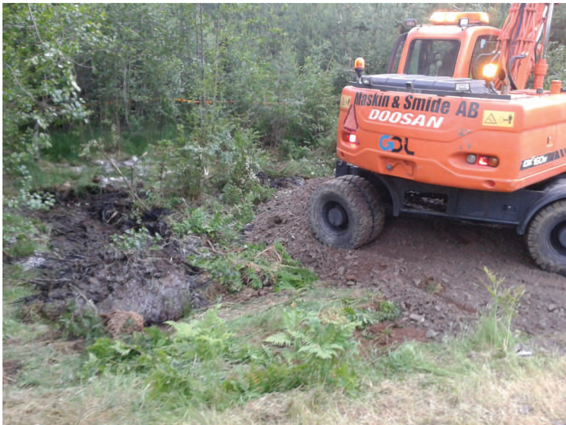
Grävningen på börjad.
