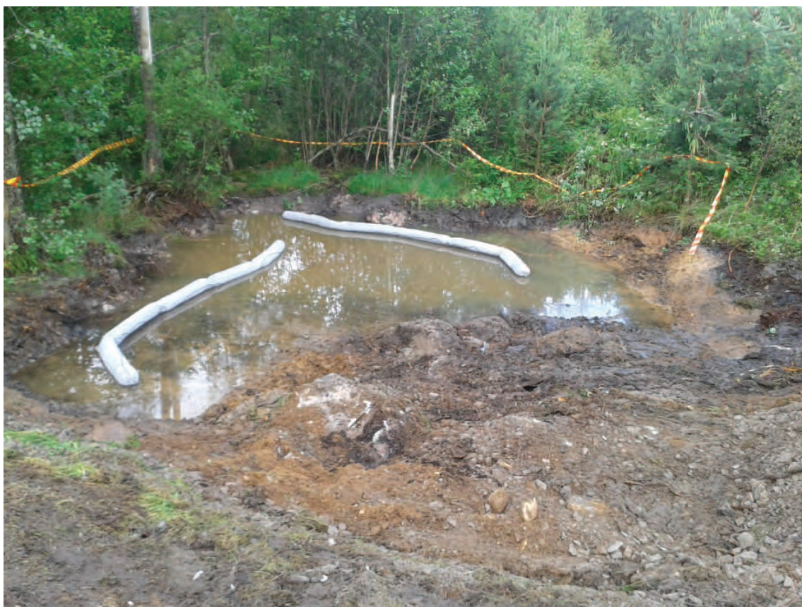
Efter grävningen så rann vatten till, länsor las ut man kunde både se och lukta diesel.
