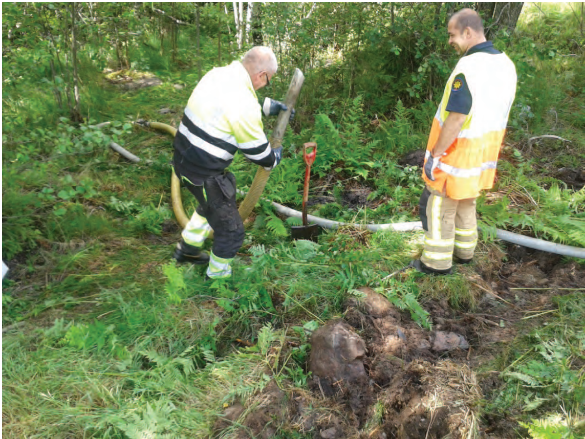
Slamsugning av vatten och diesel.
