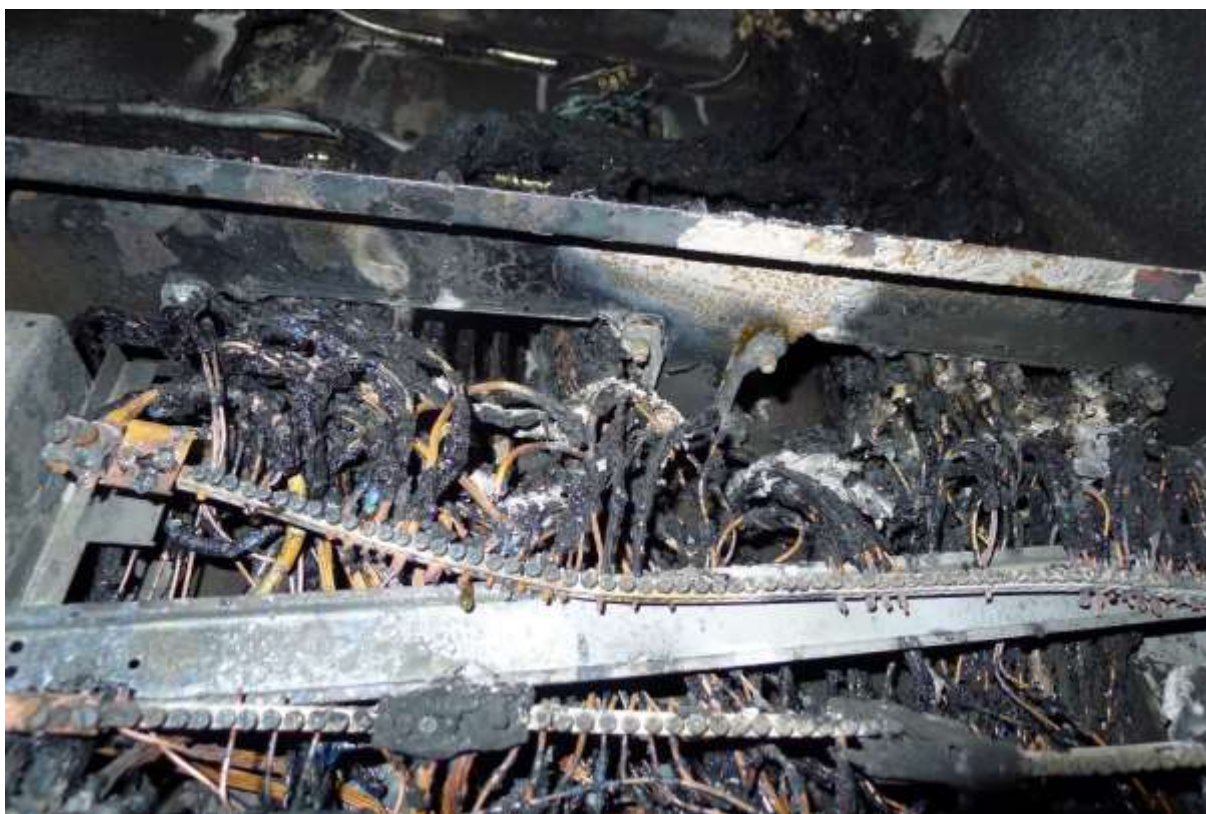
Bild 6. Brand V på insida dörr samt nersmält samt styrutrustning för fläktar.
