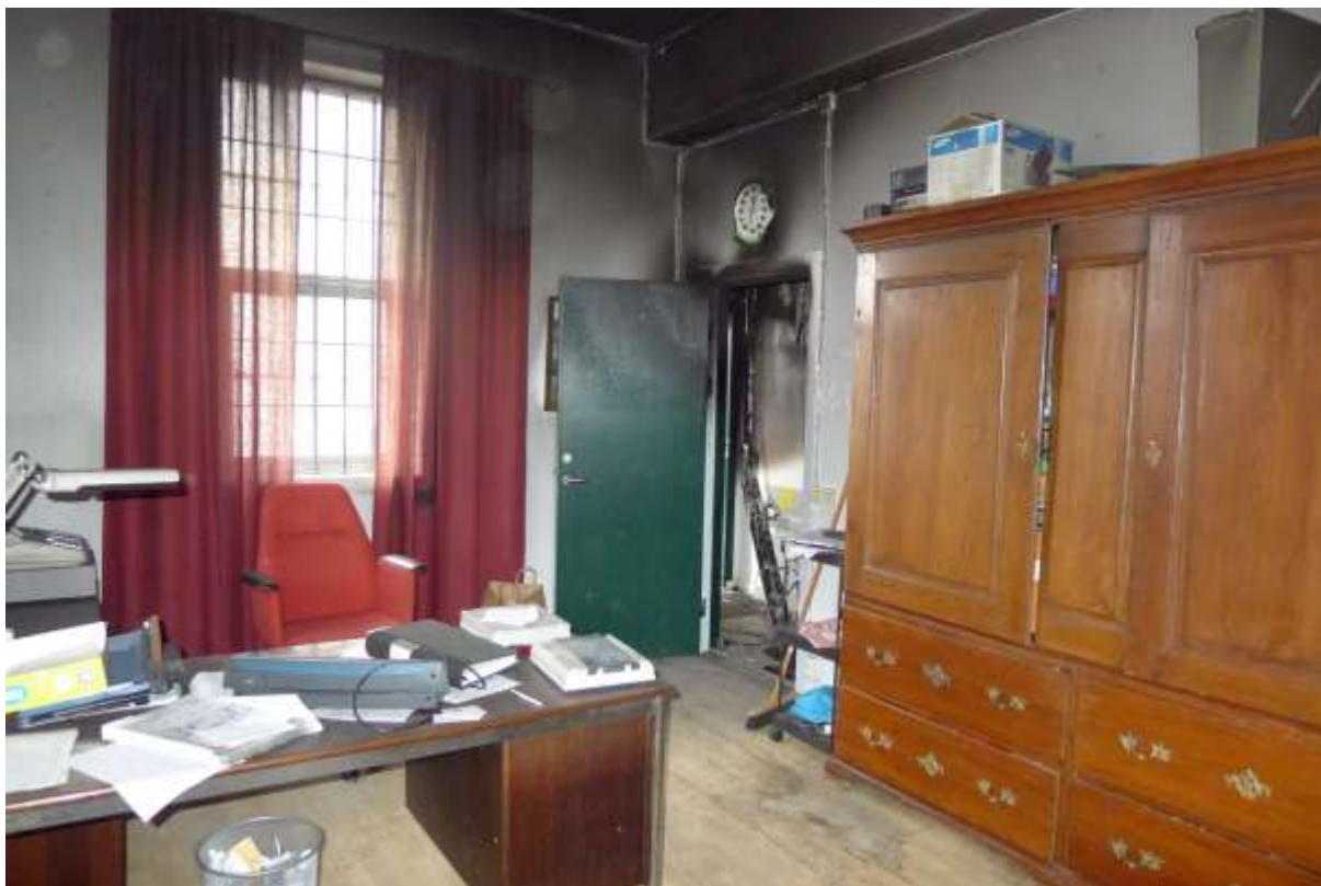
Bild 4. Kontorsrum med dörr mot hall. Endast sot och mindre smältskada på klockan
