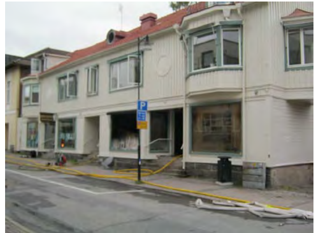
Bild 12. Ingången som användes vid restvärdesräddningen.
