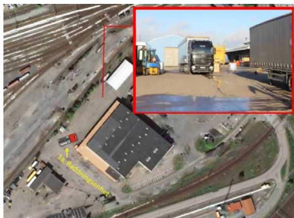
Bild 5. Skadeplatsen. Lastbilen i mitten av fotot är pålastningsplatsen där läckaget inträffade.
