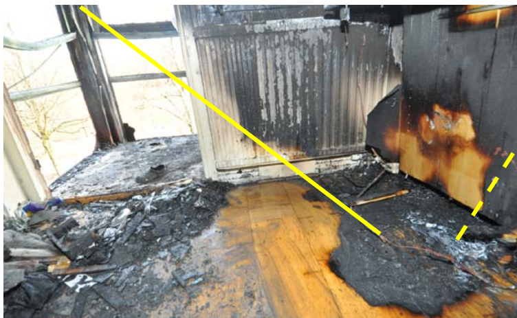
Bild 4. Tydligt "brand-V" visar var den första branden startade (Foto från polisens kriminaltekniker)
