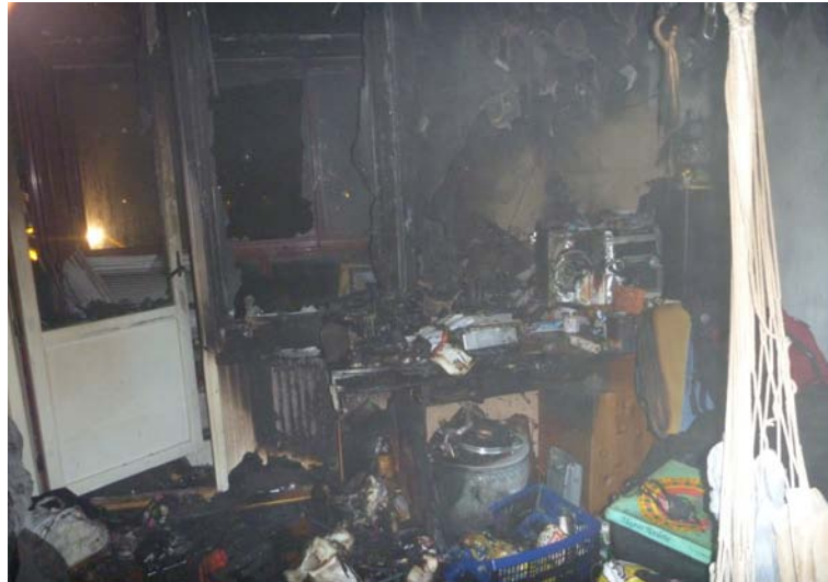
Bild 6. Brandskador kring skrivbord/fönster (Foto från RSG:s insatsrapport)
