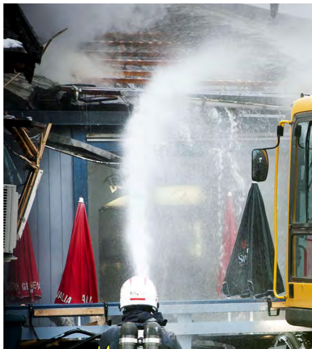
Foto 4 Rivning av tak med grävmaskin.
