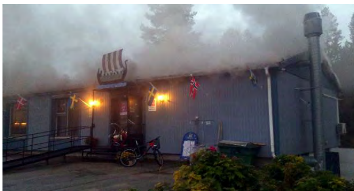
Foto 3 Restaurangen kl. 06:52 på bilden syns att det var rökspridning på hela vinden vid denna tidpunkt.
