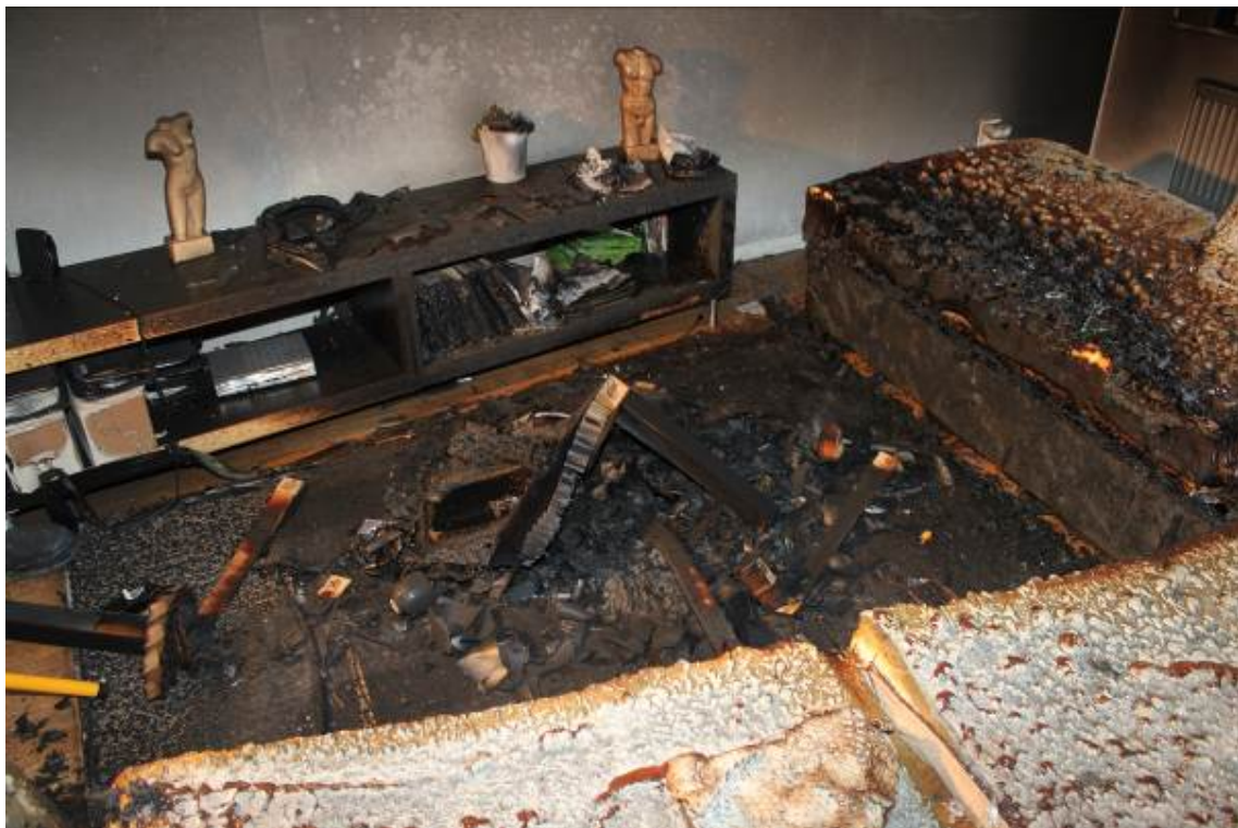
Bild 2. Primär brandplatsen var på rumsbordet mellan sofforna.
