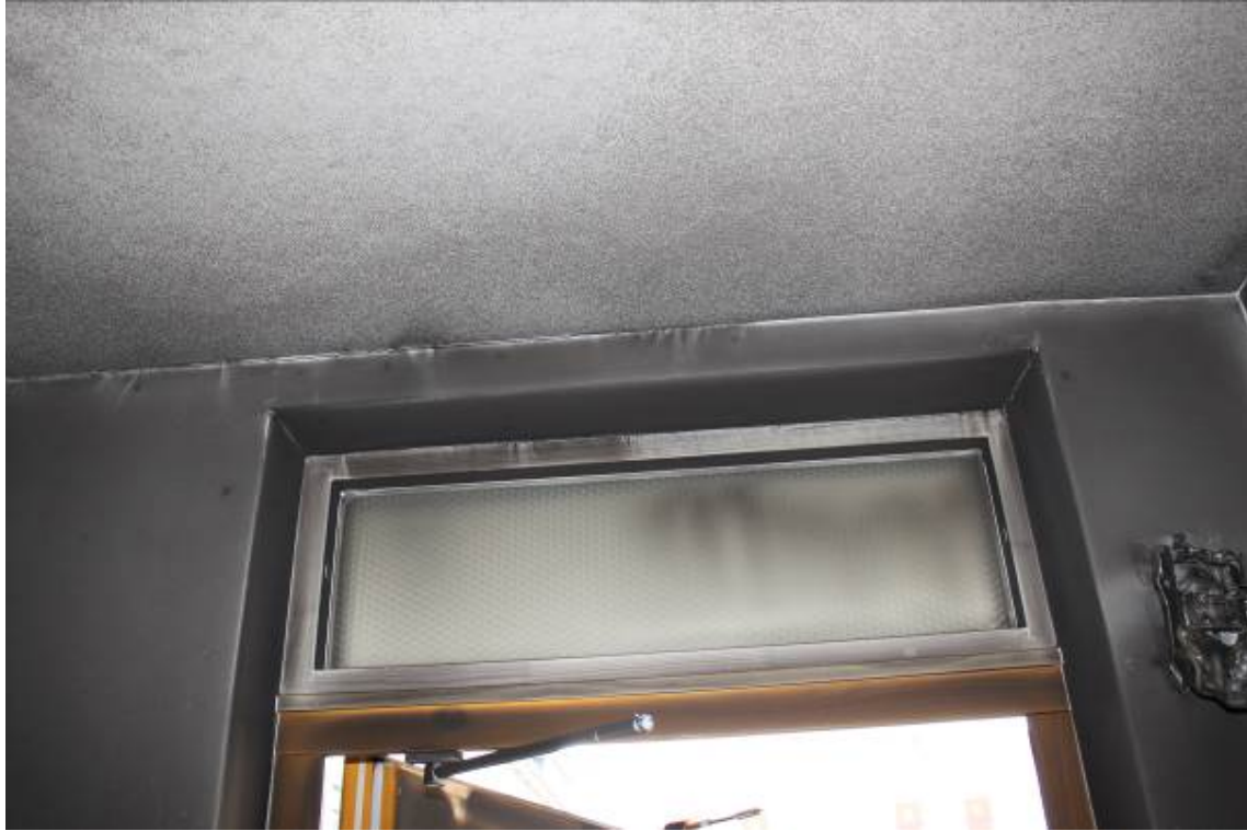
Bild 5. Otätheter ovanför ytterdörren på insidan av lägenheten.
