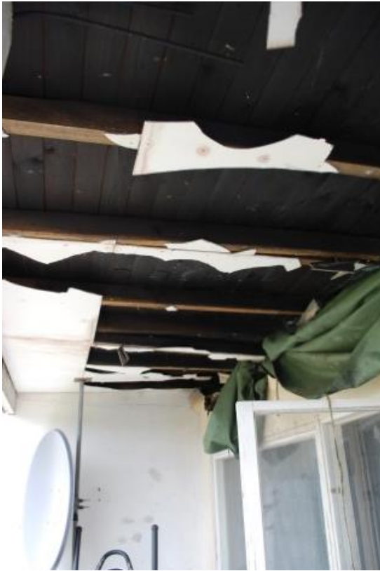
Bild 4. Takkonstruktionen med mineritskivor ovanför balkongen.
