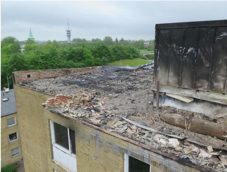
Bild 1. Betongbjälklag mellan lägenheterna och vinden.
