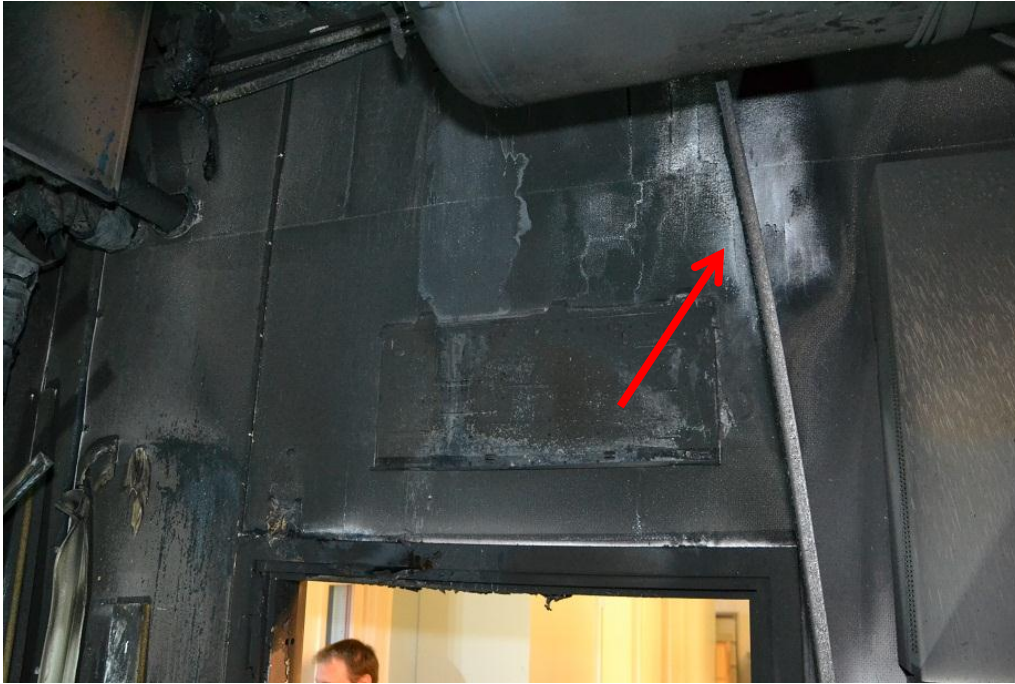
Bild: Området runt fästeanordningen till kylaggregatet. Röd pil visar exempel på "renbränd" yta.
