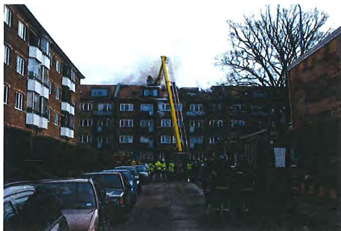
Figur 20, Ledningsplatsen valdes på gatan och bild överförs till bakre ledning
