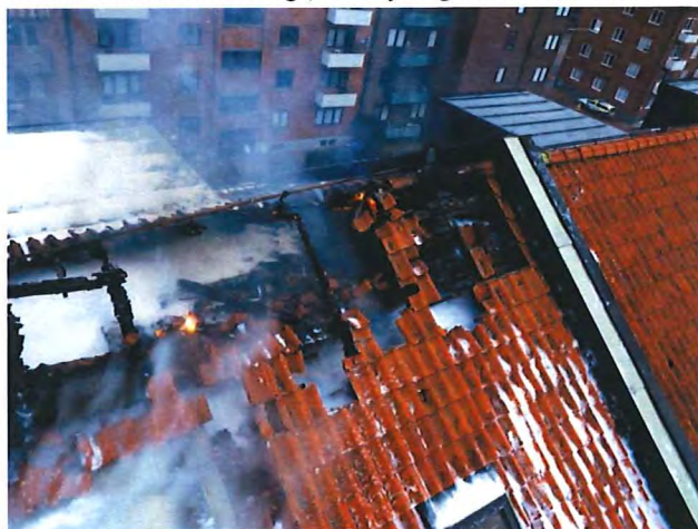
Figur 19, Mellanskum som ligger på vindsbjälklaget
