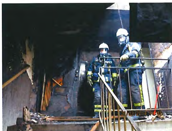
Figur 8, Foto från trapphuset, branden har tagit sig i motsatt lägenhetsdörr
