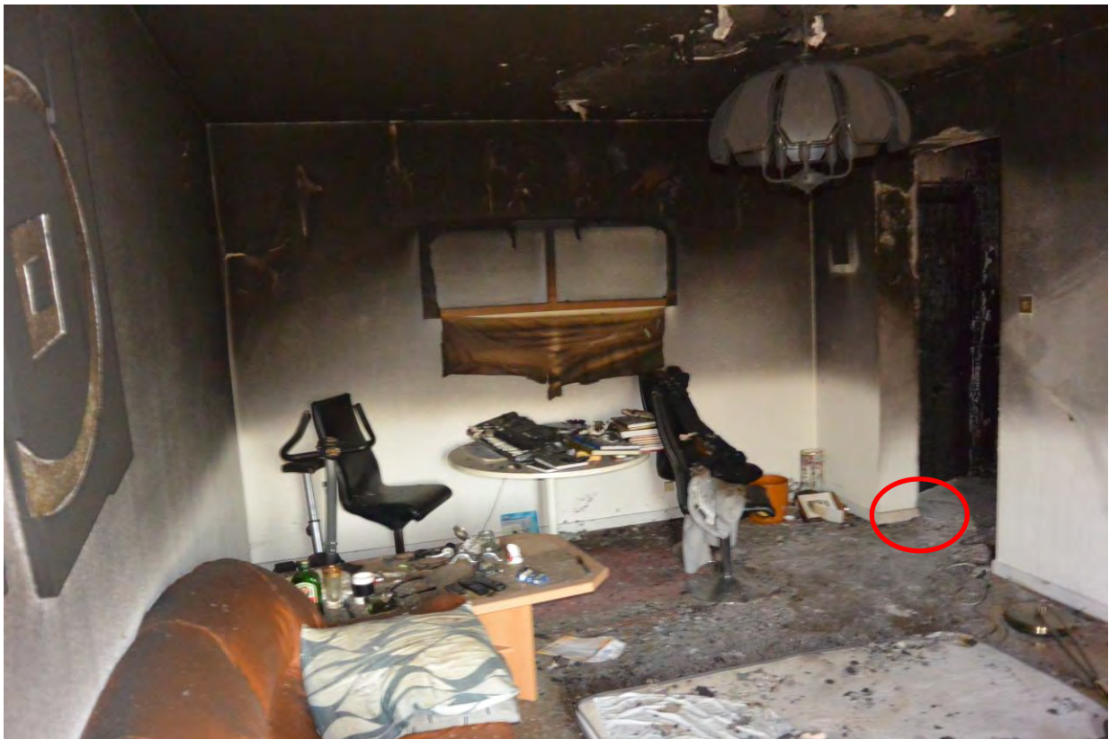
Figur 6. Fotografi taget i vardagsrummet. Gränsen mellan varma brandgaser och kall luft (nollplanet) framgår tydligt. Hörnet i den röda ringen har fotograferats på nära håll, se nästa figur. I detta rum hittades en person liggandes på golvet.
