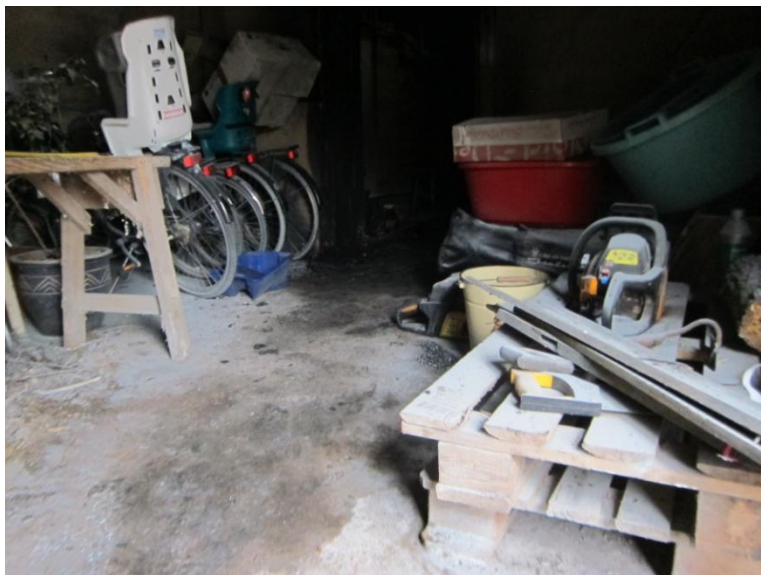
Bild 3. Brännbart material i förrådsdelen. Platsdetaljer på cyklarna var påverkade av värmen från branden.
