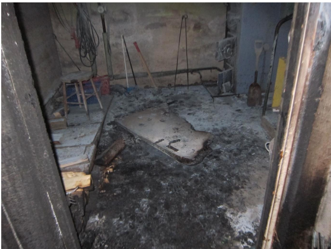
Bild 7. Pannrummet från förrådsdelen sett. Till höger syns pannan. Dörren låg i mitten av rummet när rökdykarna kom in. Till höger finns dörren in till bostadsdelen (syns ej i bild).
