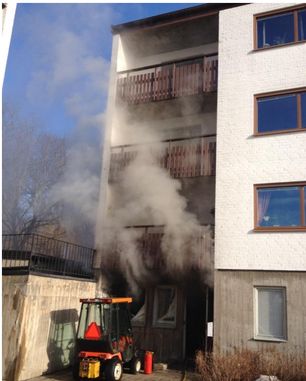
Bild 2. En ruta var sönder vid framkomst och lågor syns i rummet. Från lokalen syns kraftig rökutveckling.
