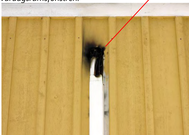
Bild 3. Kabelgenomföring i ytterväggen.
