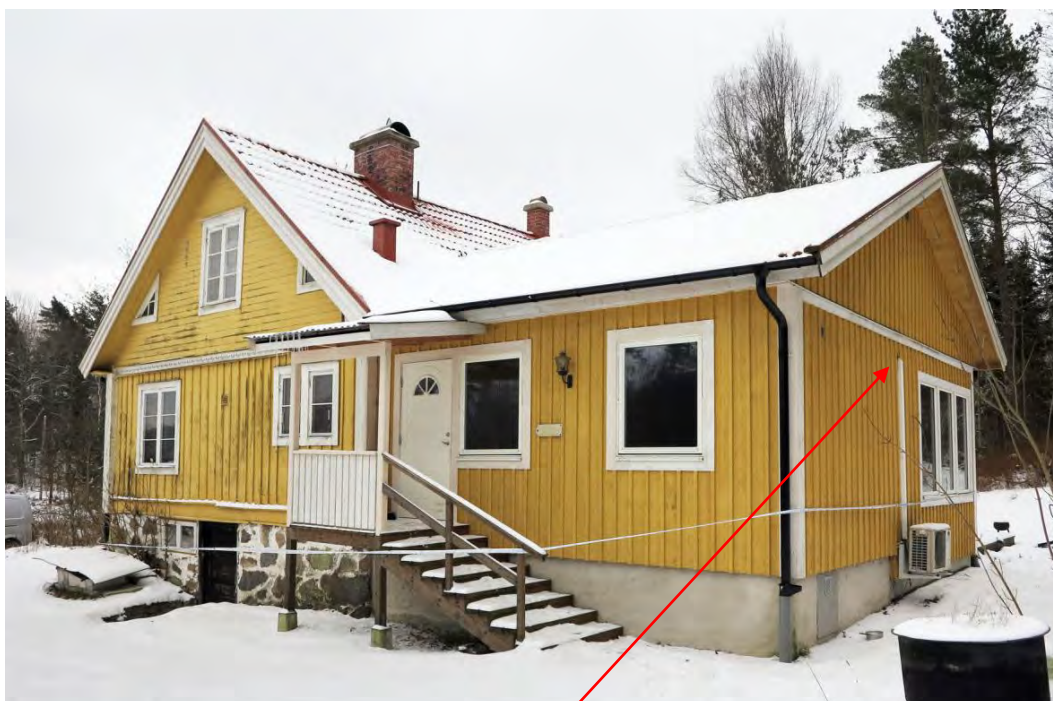
Bild 2. Vardagsrumsdelen. Till höger i bild syns kabelgenomföringen bredvid vardagsrumsfönstren.
