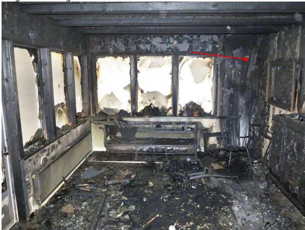
Bild 4. Vardagsrummet i tillbyggnaden, innerdelen till värmepumpen markerad.
