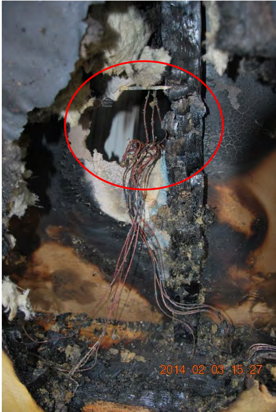
Inifrån väggen ut mot elementet, se föregående bild sid 14.
