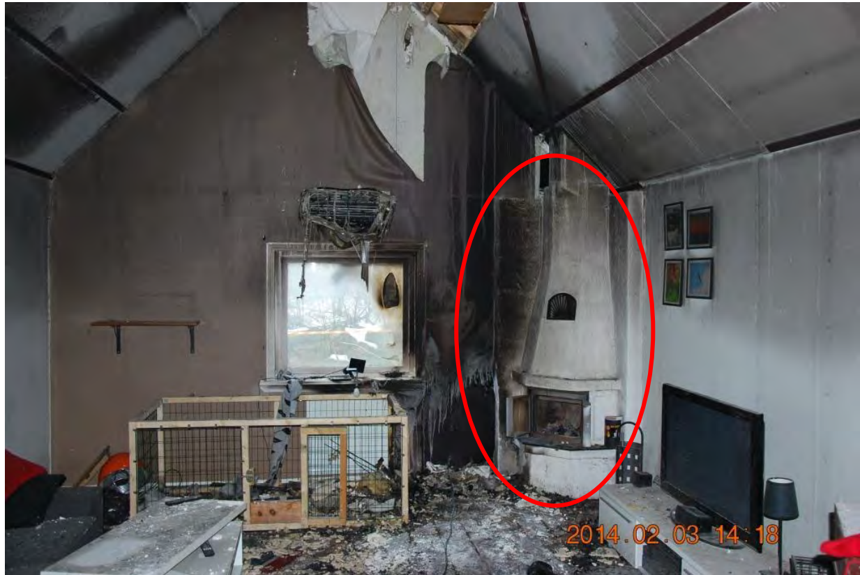
Gjutjärnskaaminen i inmurad spiskonstruktion
