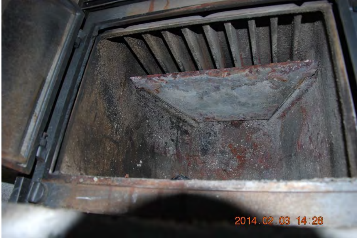
Insida av kaminen med buffelplåt inget anmärkningsvärt.
