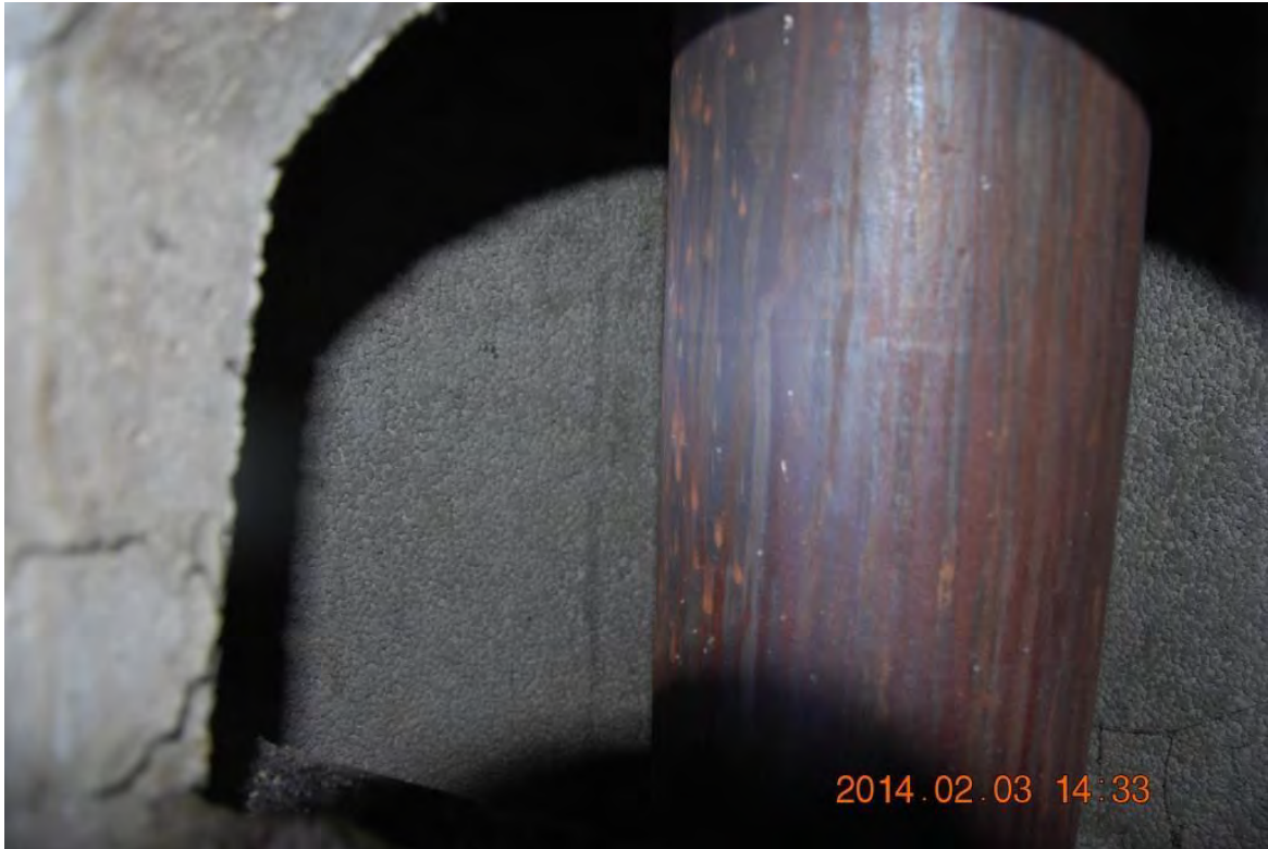
Bilder från skorstens schakt.
