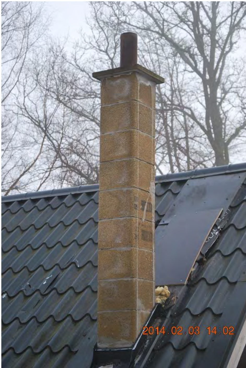
Skorstenen i keramiska lecablock som är isolerade.
