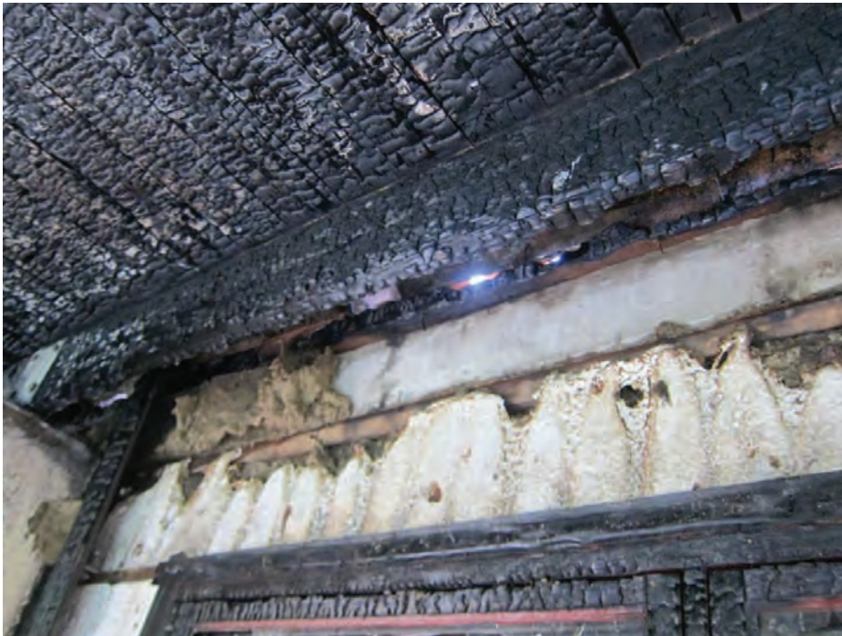
Bild 2. Balkongen underifrån, med otätheter upp mot vinden.
