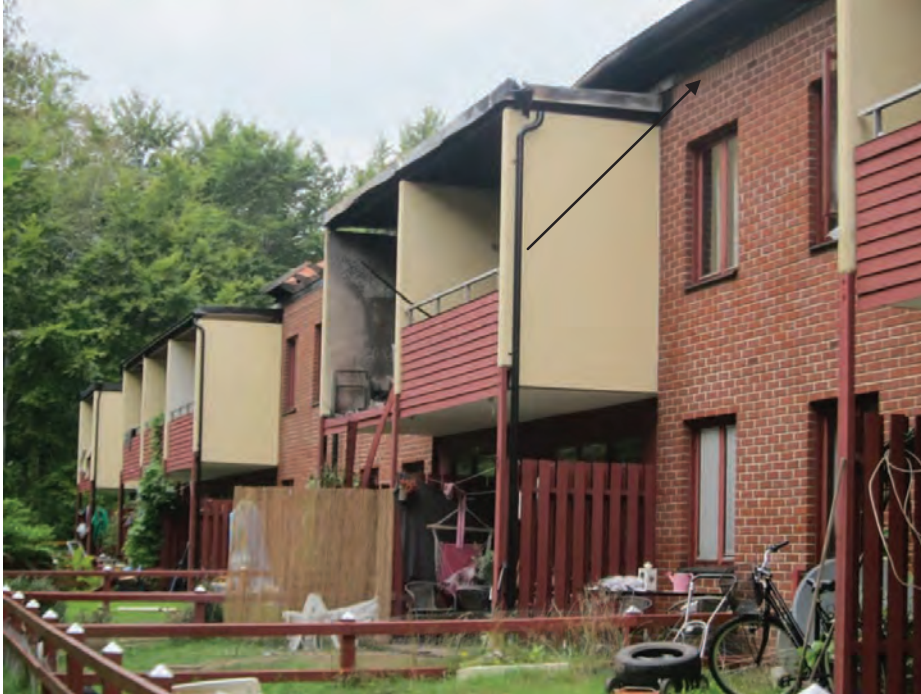
Bild 1. Fönster från motsvarande sida av balkongen med takfot (pilen).
