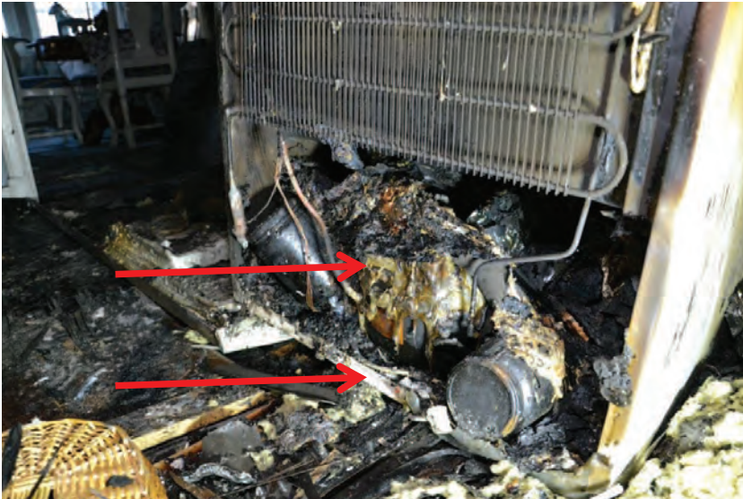
Bild från kylens kompressorenhet. Här syns smältskador av plast (ovanifrån) men en renare underkant än frysen.
