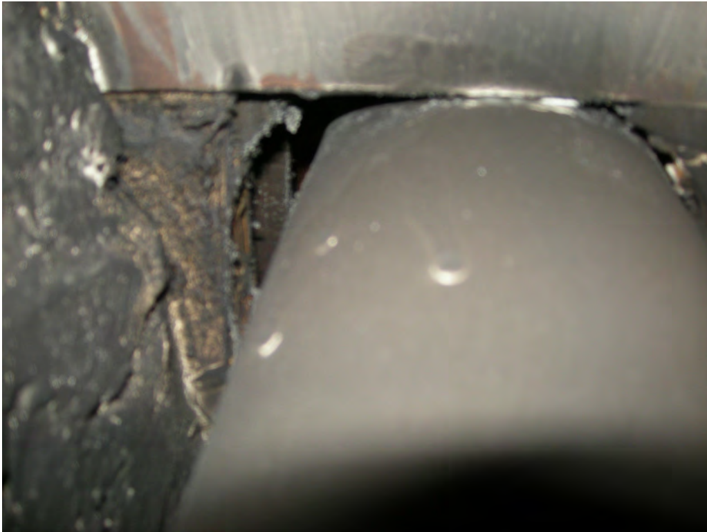
Figur 6, Otätheter i rördragning
