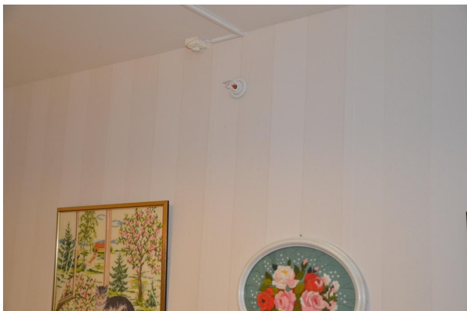
Vägg monterad sprinker
