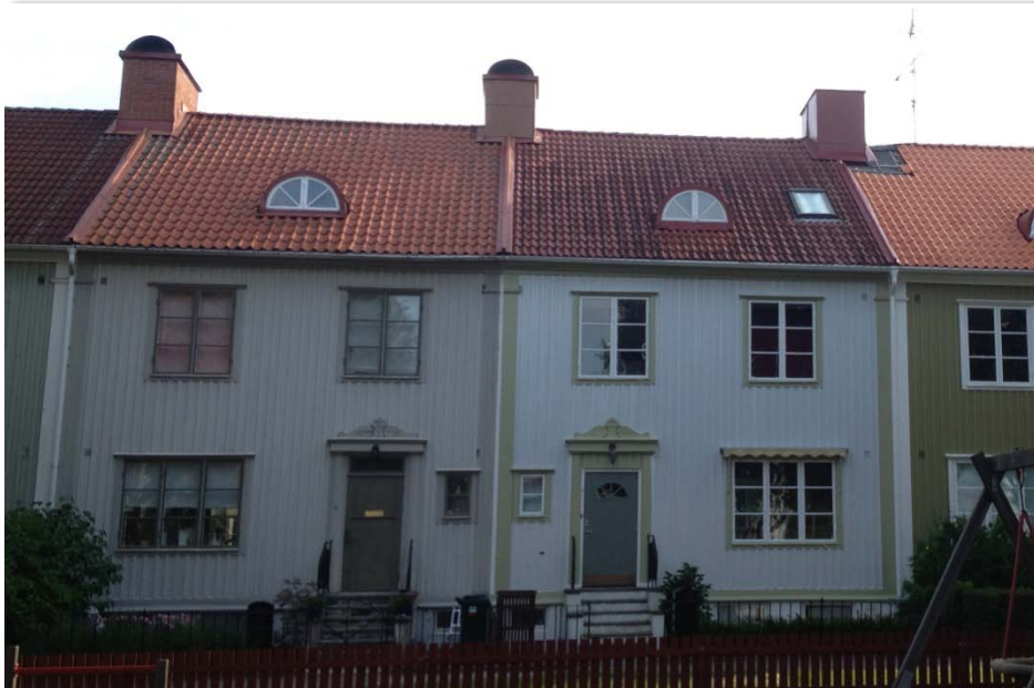
Bild 8. Fastigheterna avgränsas på taket med plåtar.
