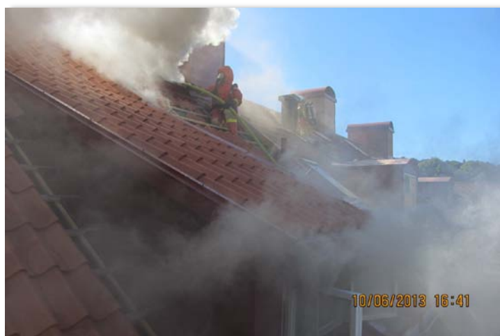
Bild 3. Släckningsarbete på fastighetens tak.
