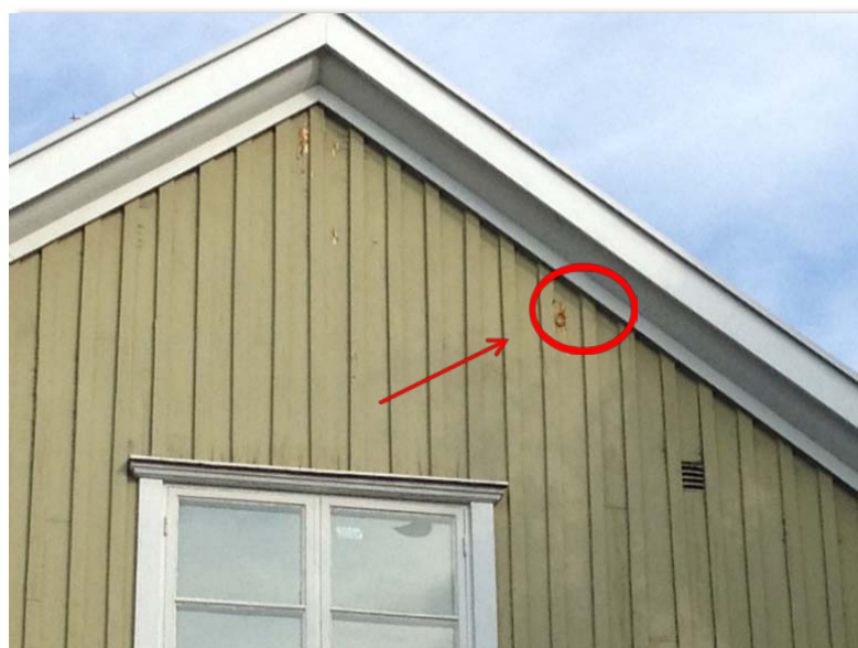
Bild 5. Ingångshål för skärsläckaren.
