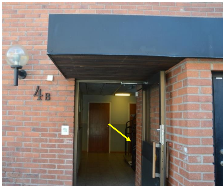
Bild 1 Entré med nedgång till nedre våningen till höger.
