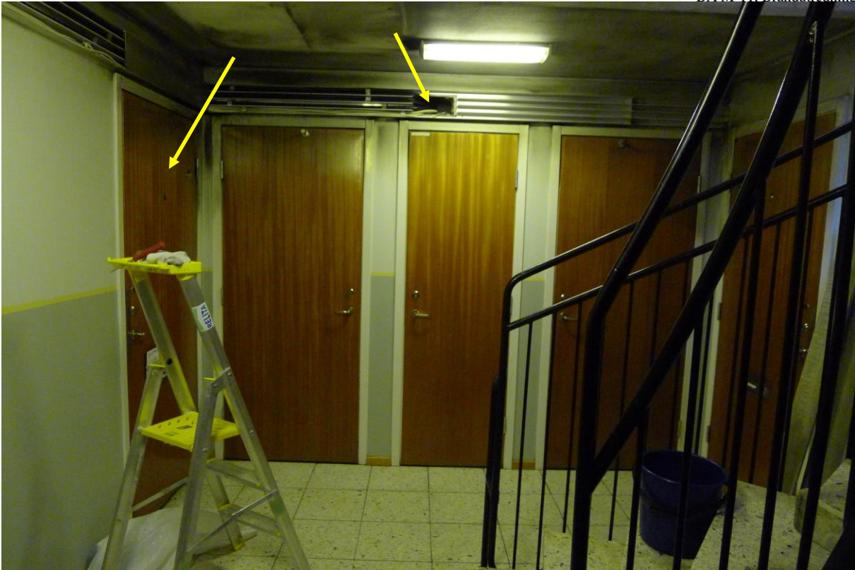
Bild 4. Dörren till brandlägenheten samt håltagning för kabeldragning utmärkt.
