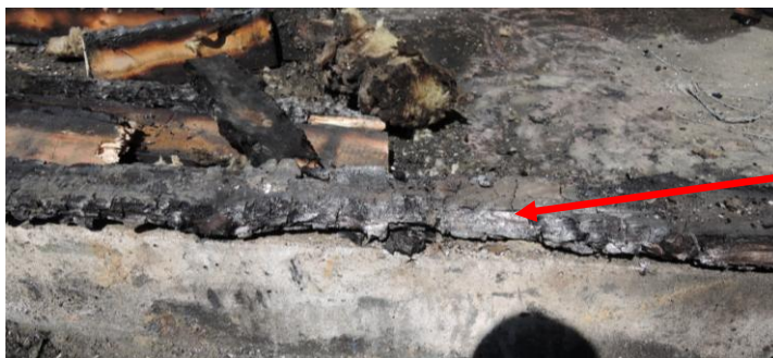
Bild 4. Den förkolnade träbalken på golvet.
