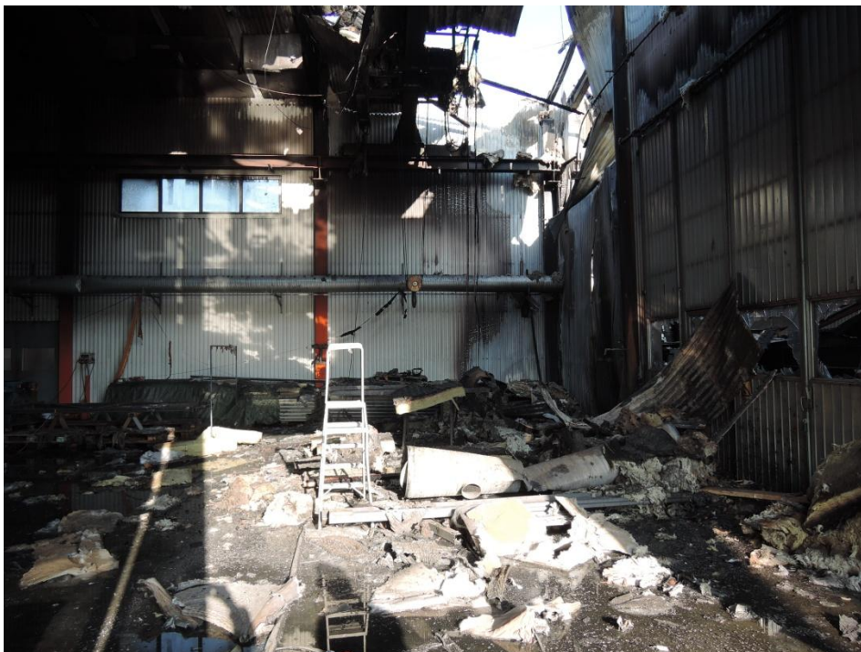
Bild 6. Verkstadshallen. Till höger syns väggen mellan hallarna samt port 4.
